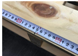
4 上板45cmに印を付け、真ん中の桁の芯と合わせて下さい。
